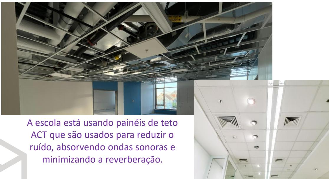
A escola está usando painéis de teto ACT que são usados para reduzir o ruído, absorvendo ondas sonoras e minimizando a reverberação.
